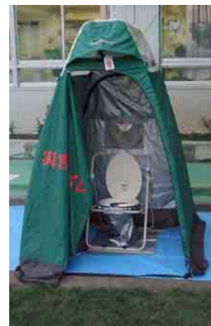
マンホールトイレ設置の様子
