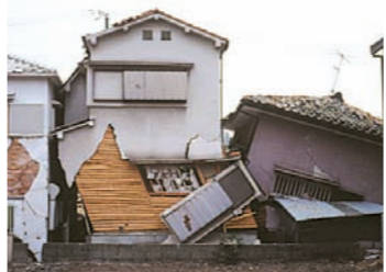
耐震性の低い典型的な例。筋交いは外れ、鉄筋が入っていない基礎は大きくひび割れている
