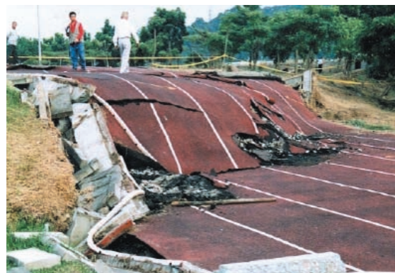
1999年に発生した台湾集集地震での地表地震断層元は陸上競技場のトラックだが、上下に大きくズレている
