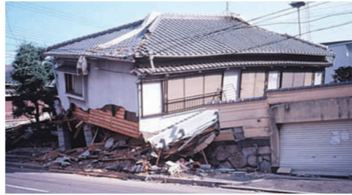
◀1階の耐力不足でせん断変形した典型的な被害例 耐力壁の配置のバランスが悪いうえに接合が外れた典型例▶
