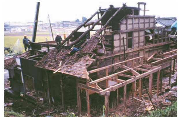
解体調査の様子 登り梁にスギ丸太を高い大工技術により、そのまま使用している。手前は増築部分
