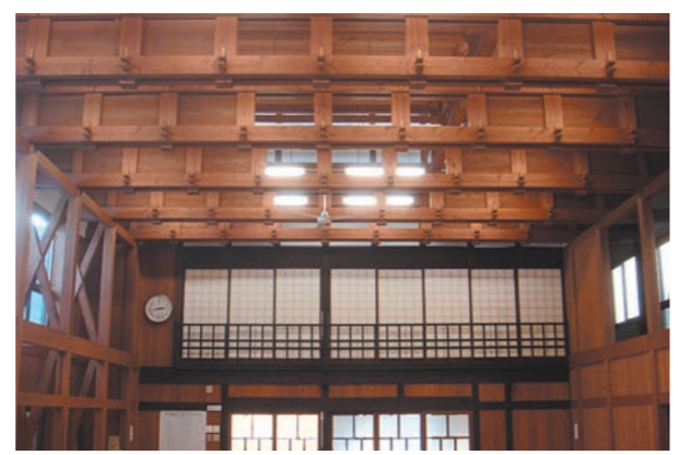
伝統の技を現代に合うように活かし、構造設計された建築物
