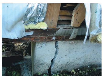
耐震性の低い典型的な例。筋交いは外れ、鉄筋が入っていない基礎は大きくひび割れている
