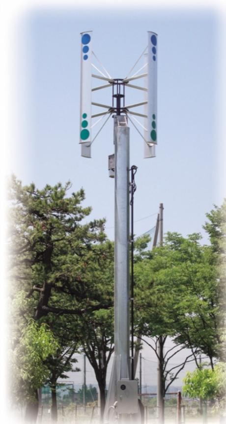
長さ二m、定格出力七六〇W(風速二二m/s時)、風車中心までの高さ六・七mです。この風車の特徴は、①水平軸型のプロペラ式風車と異なり垂直軸型なので、日本における風況の特徴である風向変動にも制御機構なしで対応できる構造になっていること、②プロペラ式と比較して風車の回転数が低いので低騒音であるこ
