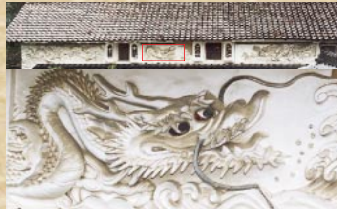
図1 砺波市名越家土蔵の双龍(上:全体)(下:赤枠部分の拡大)
