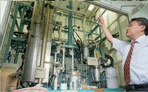
天然ガスから合成液体燃料を生成するプラント
