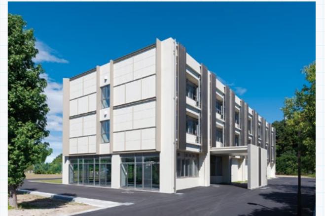
軽金属材料共同研究棟(Plant Zero)
