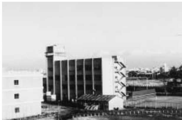
和漢薬研究施設棟（薬学部2号館方向）
