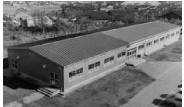
移転を決めていた工学部には、文部省はプレハブの講義棟しか建ててくれなかった（昭和53年）（北日本新聞社提供）
