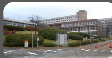
着工前写真（北西面）
