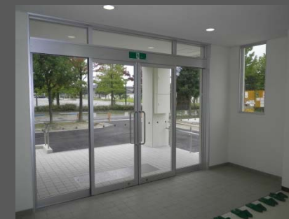
完成写真 (内観)
