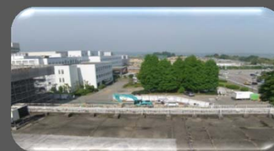
着工前写真 (屋上)
