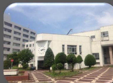
着工前写真（講義棟外観）
