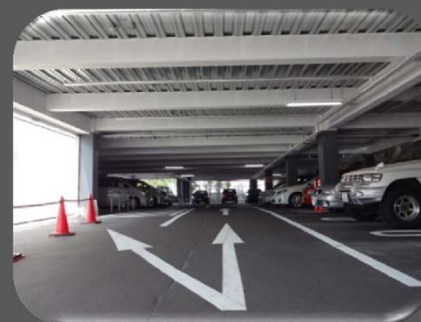
完成写真（内部）
