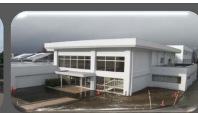
完成写真 (玄関)
