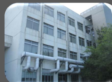
着工前写真（実習棟外観）
