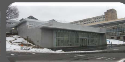
完成写真（北西面）
