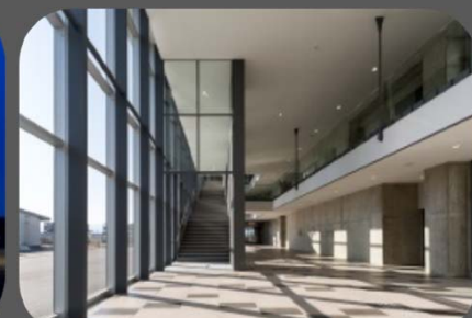
完成写真（内観）
