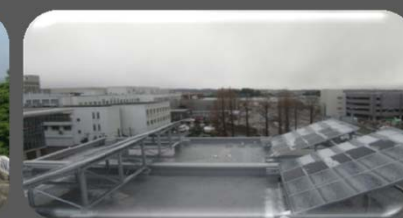
完成写真 (屋上)
