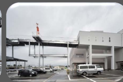
完成写真（渡り廊下）
