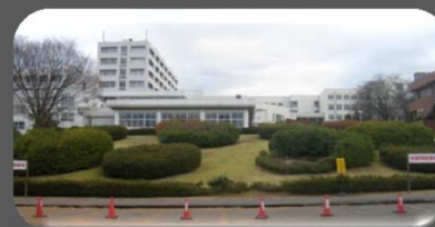
着工前写真（西面）
