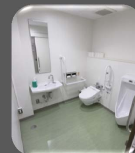
完成（多目的便所）
