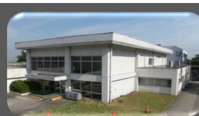
着工前写真 (玄関)
