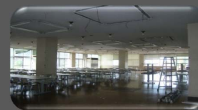
着工前写真 (食堂)
