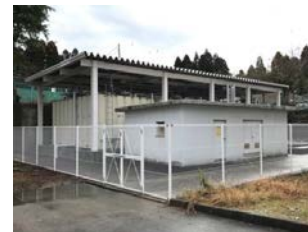
R I排水処理設備(附帯設備)
