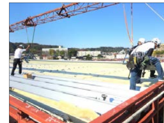
屋根：2重折板葺き施工吹付状況
