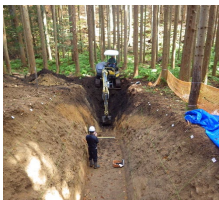
ショベルカーによる掘削の例
