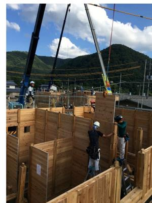
板倉構法による応急仮設住宅建設の様子
